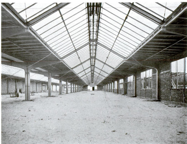
Neuartige Heilmittelkonstruktion gebildet aus eisernen Krüppeln und aufgestreutem Oberfläch. Prof. Peter Behrens Nouvelle manière de construction à l'aide de simples ferres et de briques en verre New mode of construction build in cooperation with Behrens & Co.
